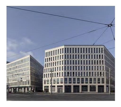
Stützen und Bändern mit dazwischenliegenden geschosshohen Fenstern ohne erkennbare Rahmungen. Sichtbare Fugen dienen zur Untergliederung der Flächen und werden geschlossen verfugt und besandet, alle übrigen Fugen werden als Pressfugen bei durchlaufender Plattenstruktur ausgebildet.
