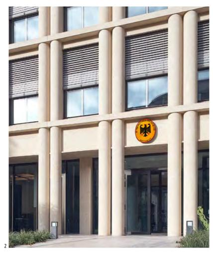
jeweils 3 m aus einem Stück gefertigt wurden, sind im Erdgeschoss bis auf dem Boden geführt worden, so hat die Fassade damit seine bis dahin fehlende aber notwendige Erdung erhalten.
